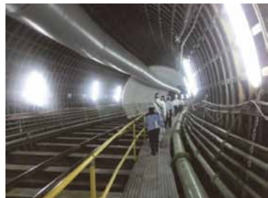
トンネル坑内（曲線部から直線部へ）
