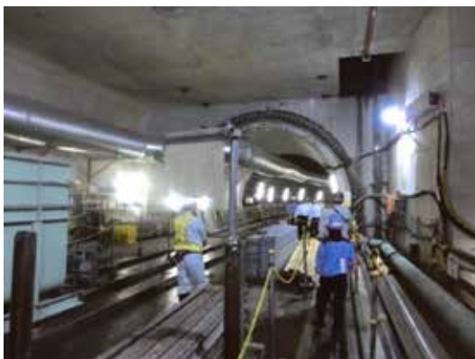
発進立坑部からトンネル入口部状況
