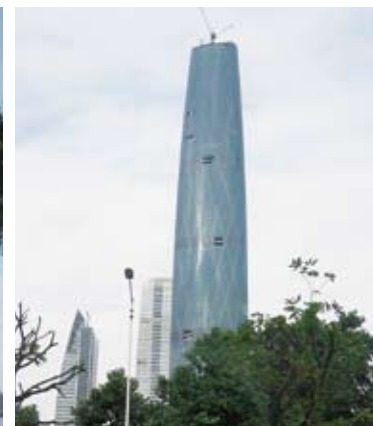
広州珠江新城核心区広州市西塔438m
